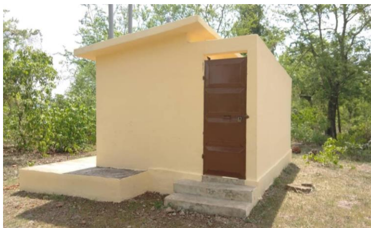
Figure 5 : latrine moderne de la communauté chrétienne catholique construite à Abotessé
